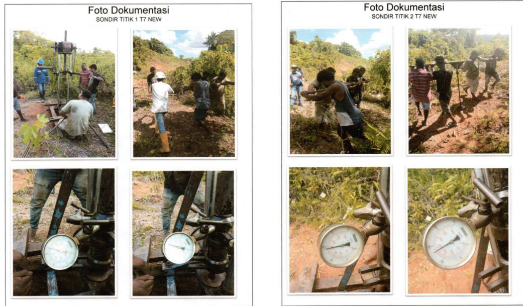
Gambar 3.5 Dokumentasi Penyelidikan Tanah
