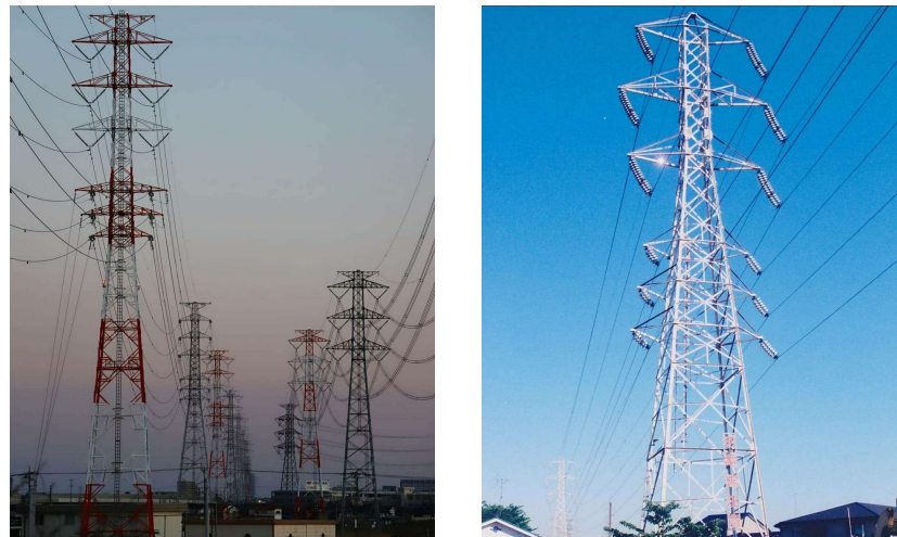
Gambar 2.13 Tower 4 sirkit tipe suspensi (kiri) dan tension (kanan).
